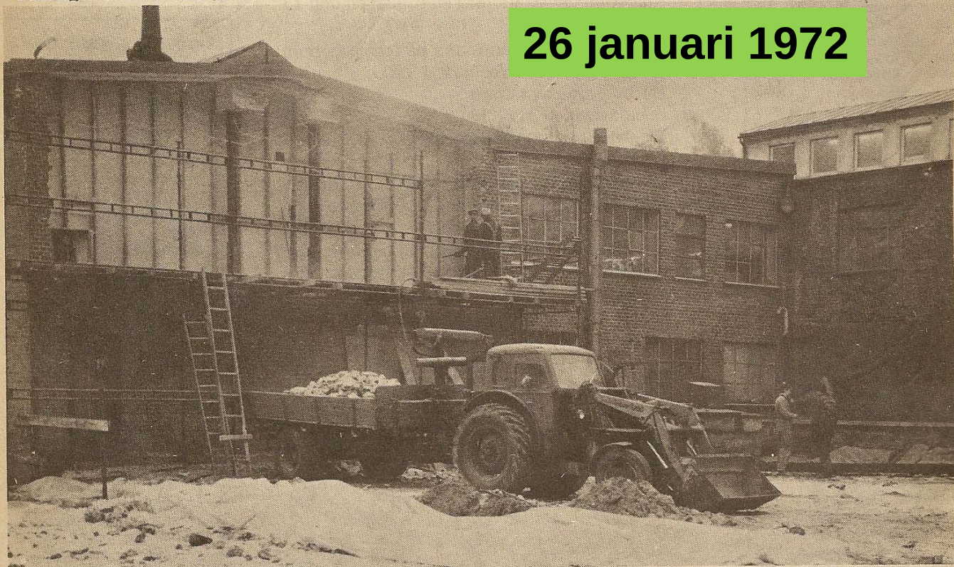
Schaktningsarbetena för det nya bygget vid SVA har redan börjat. I bakgrunden syns den gamla fabriken ena vägg där man tagit bort teglet för att kunna ansluta den nya byggnaden.
